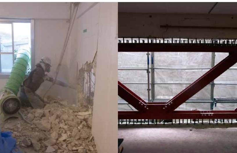
耐震改修工事（2011年1月～3月）
